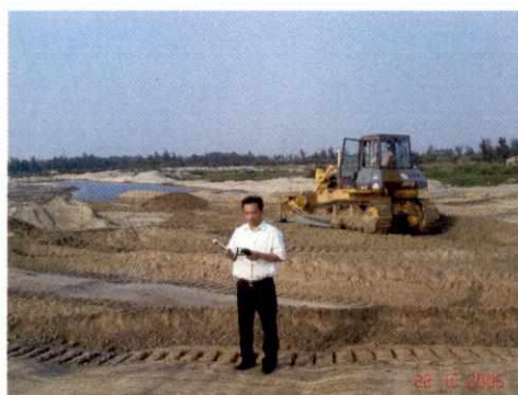
ĐO CHẤT LƯỢNG KHÔNG KHÍ NƠI ĐANG THI CÔNG
