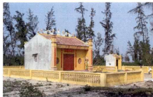
MIẾU THÔN VỸ (MỚI XÂY DỰNG LẠI)
